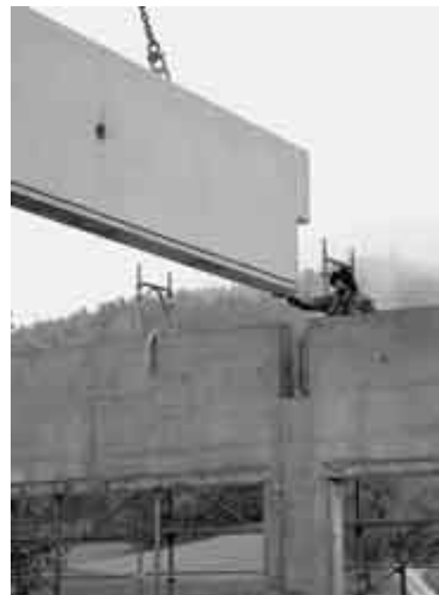
Oben: Zentimetergenau wird der 20 Tonnen schwere Träger auf die vorbereiteten Lager abgesetzt
