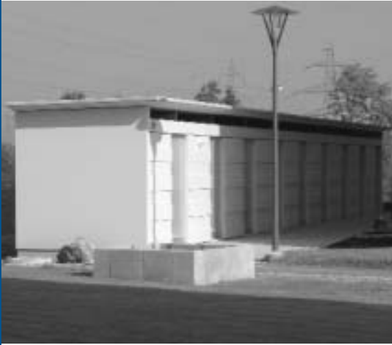
Fixfertig montiert – in gerade mal zwei Arbeitstagen
