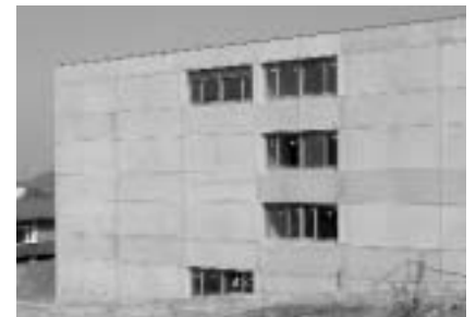
255 Elemente bilden die Haut der neuen Kantonsschule
