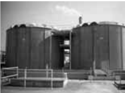
ARA Oftringen (CH)
